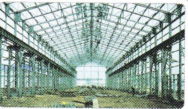
▲ Nhà xưởng/For building construction
