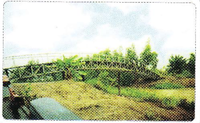
▲ Kết cấu cầu / For bridge structure
