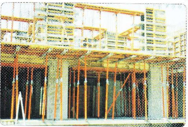
▲ Giàn giáo xây dựng/Pipe scaffoldings
