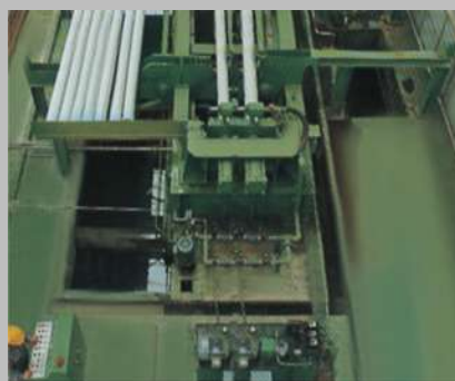
Kiểm tra áp lực / Hydrostatic Test
